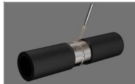
ОЧИСТКА ПОВЕРХНОСТИ СТЫКА
